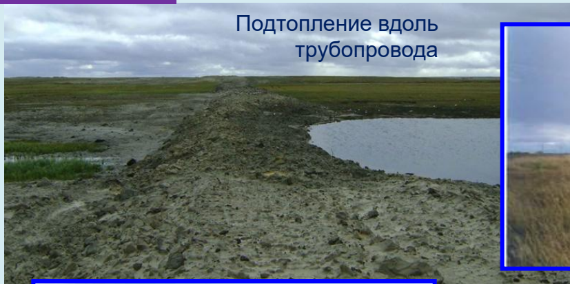
Техногенный термокарст вдоль трубопровода
