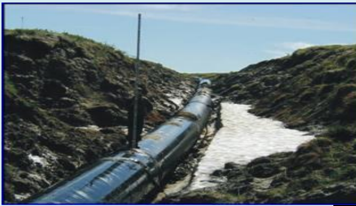
Техногенные промоины вдоль трубопровода
